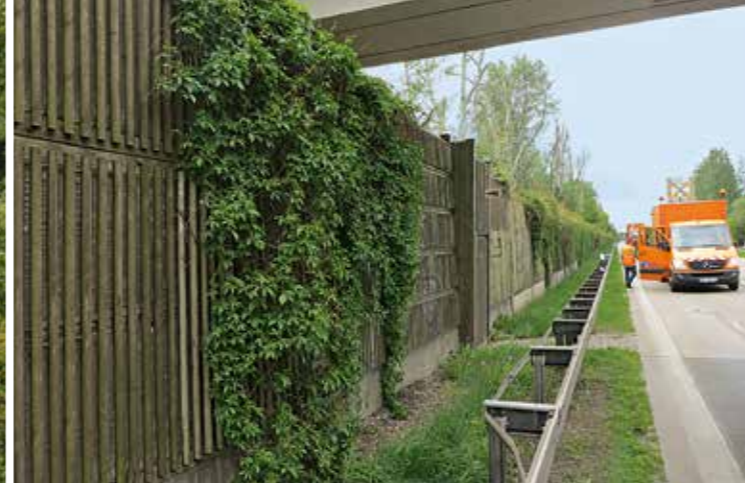
Die vorhandene Lärmschutzwand wird erhalten.
