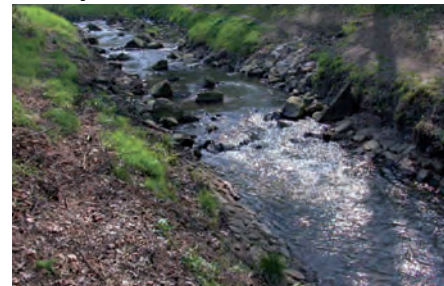
Eine Sohlgleite. Sie stellt kein Hindernis mehr dar.
