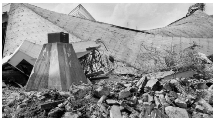
Robert Conrad: Abriss der Berliner Großgaststätte Ahornblatt. Ansicht der herabgestürzten Dachkonstruktion, 15.8.2000 © Robert-Havemann-Gesellschaft/Robert Conrad/unverzeichnet
